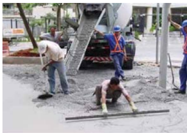
Figura 17 – Recebimento e espalhamento do concreto.
