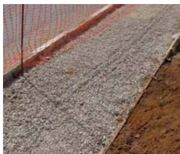
Figura 16 – Espalhamento da camada de Brita
