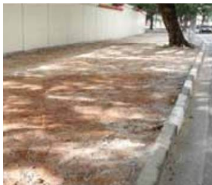
Figura 15 – Nivelamento e compactação do terreno
