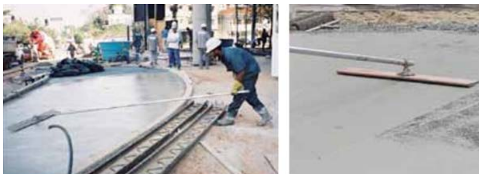
Figura 19 – Desempeno do concreto.
